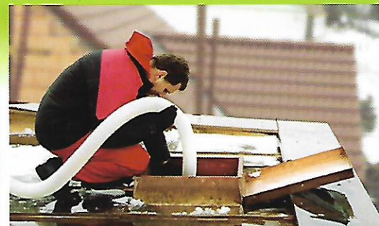
U pultových střech doporučujeme vždy osadit vikýř, je výhodný pro samotnou izolaci a jako revizní vstup do prostoru střechy.
